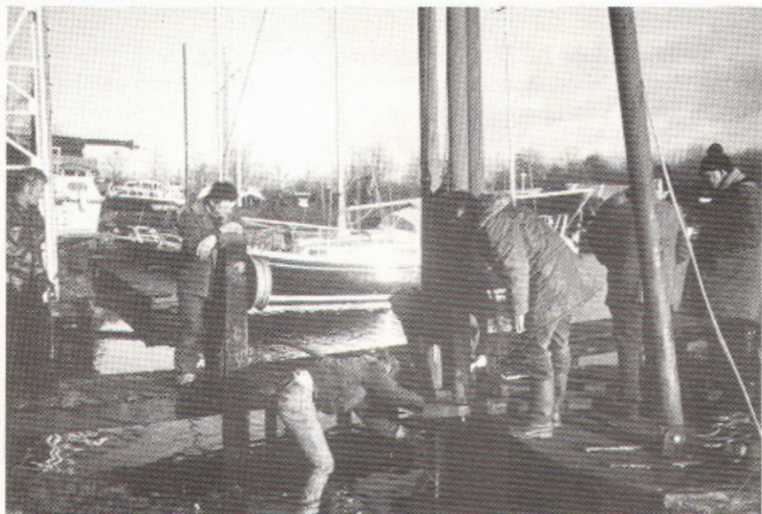
De start van de bouw van de eerste azobé-steigers. V.l.n.r. G. Huisman, G. Otten, H. Mulder, G. Eenkhoorn, G. Modders en R. Lenstra.
